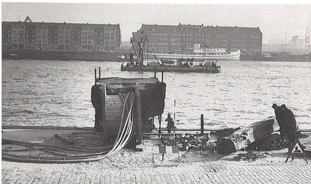
▼ Foto 3 Kabelwerkzaamheden in de Maas (Boompjes)
